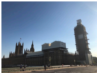
写真 2. 国会議事堂は修復工事中
